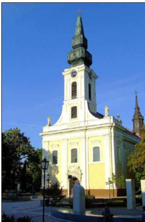
torony homlokzatának külső felújítására 14 997 514 forint.
